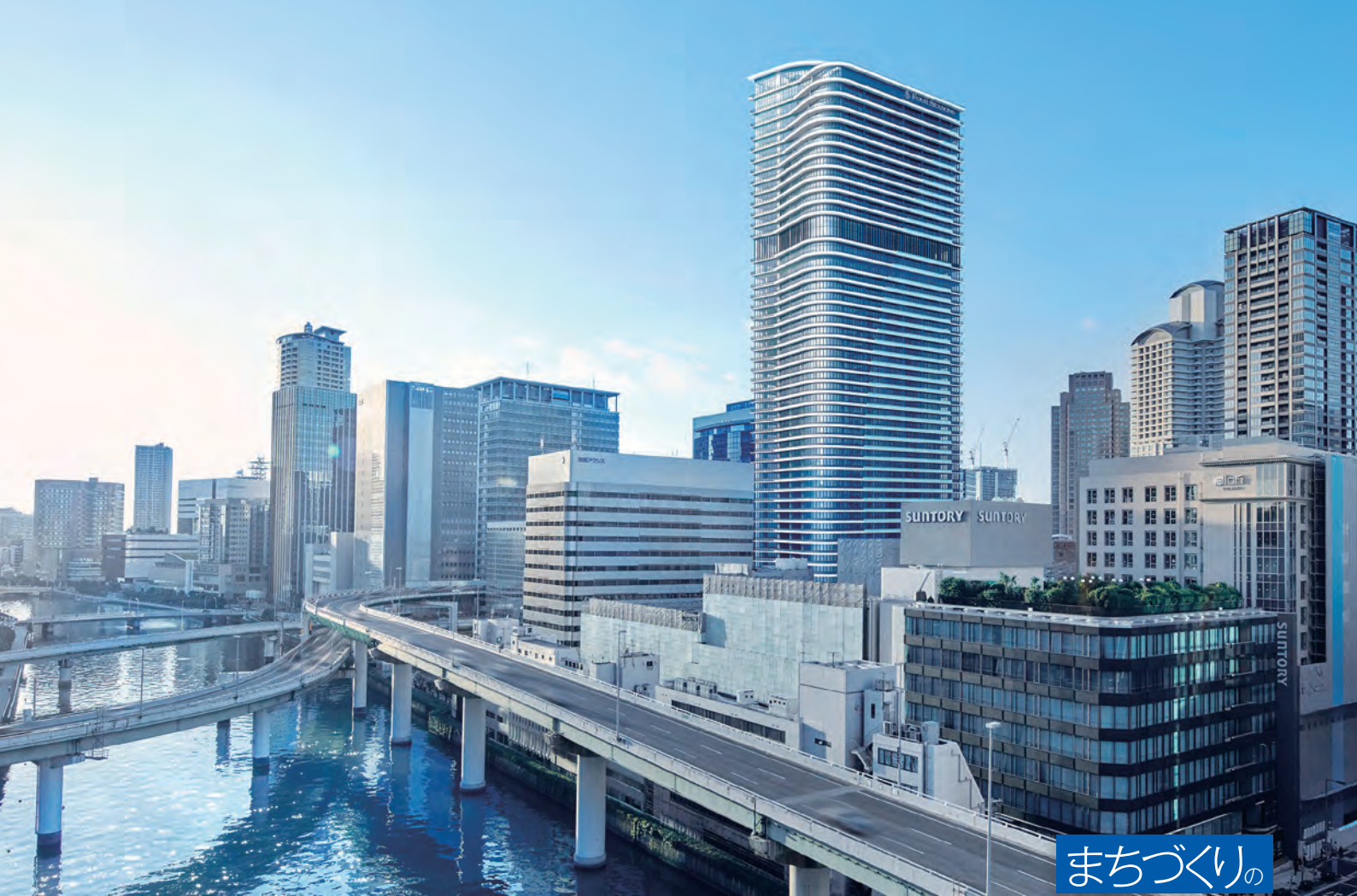
外観完成予想CG:高層ビル群でひときわ目を引く外観
