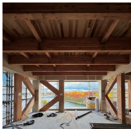
都島プロジェクトの建築現場：LVLのK型ブレース
