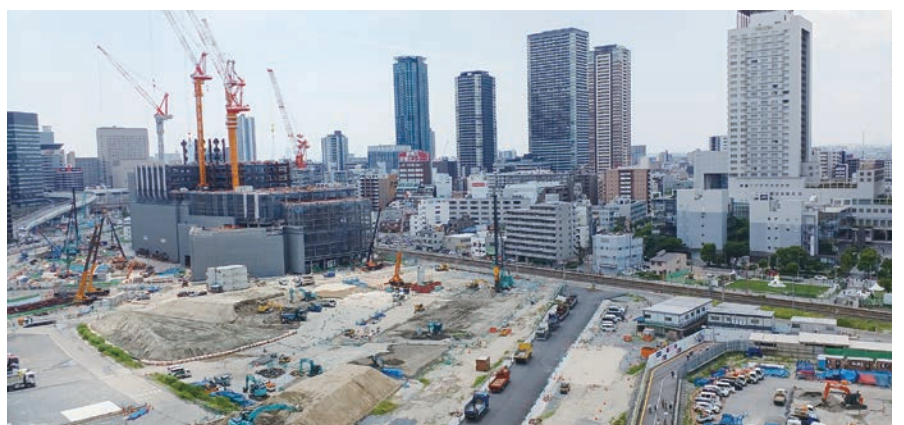
施工中のうめきた2期 左側建設中のビルは南街区 中央は(仮称)うめきた公園になる
