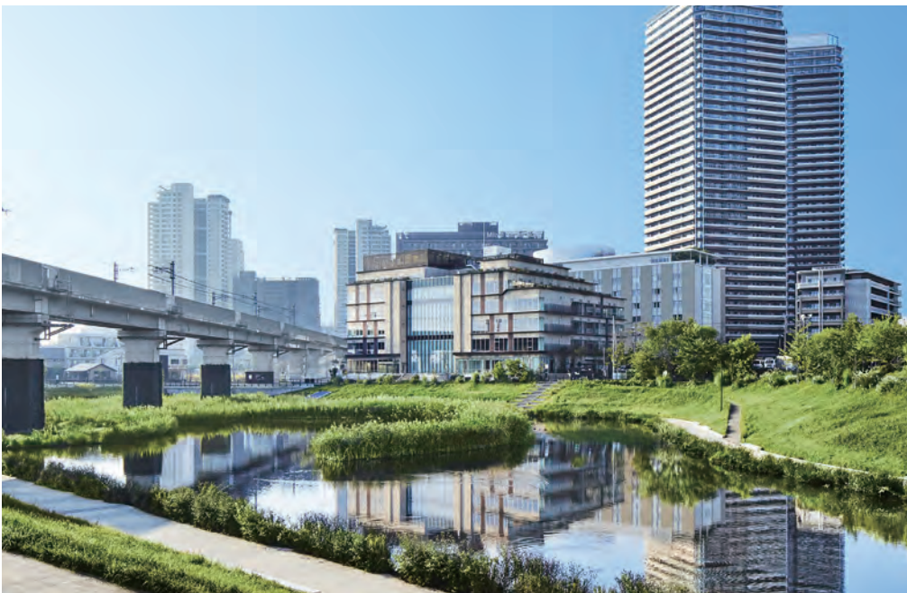
図2 雨水貯留施設のイメージ例 千葉県柏市で三井不動産が手がけた「柏の葉テラス」は親水化した雨水貯留施設（調整池）
