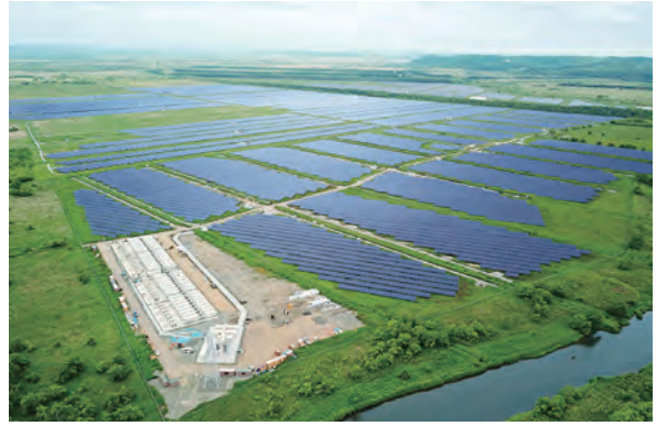
北海道釧路市にある東急不動産など3社が運営するメガソーラー発電所「すずらん釧路町太陽光発電所」
