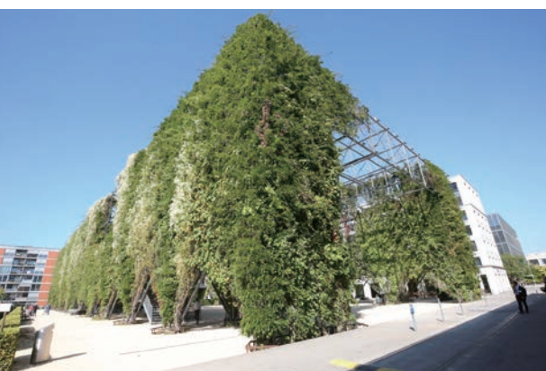
郊外にあるエルリコン地区の再開発でコミュニティのハブとしてつくられたMFOパークの巨大なパーゴラ
