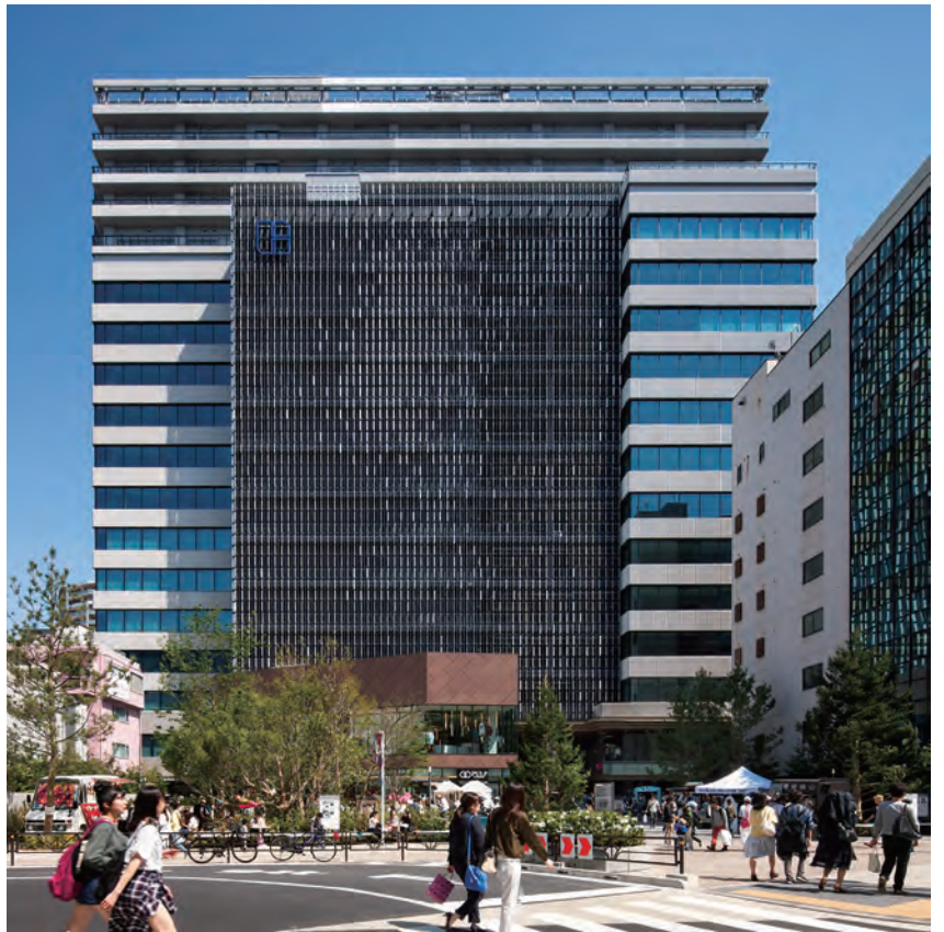
豊田啓介氏がパートナーを務める建築事務所noizがデザイン・監修を担当したSHIBUYA CASTのファサード。壁面中央の空調・設備バルコニーを覆う縦型の多数のフィンが、光の反射により時間帯、季節や天気、また人の動きに応じて「パッシブ・ダイナミック」にパターンを変化させる
