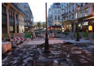
2019年、マレ地区では歩行者主体の空間へと道路を工事中であった
