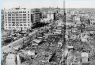
被災後の様子(東京都京橋)
